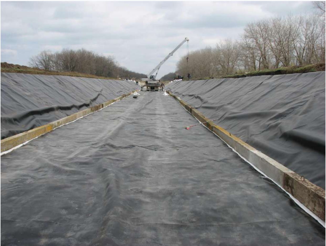
Рис. 2 - Технічний стан Інгулецького магістрального каналу після виконання ремонтних робіт (укладання геомембрани) (фото Є.В. Козленко).
