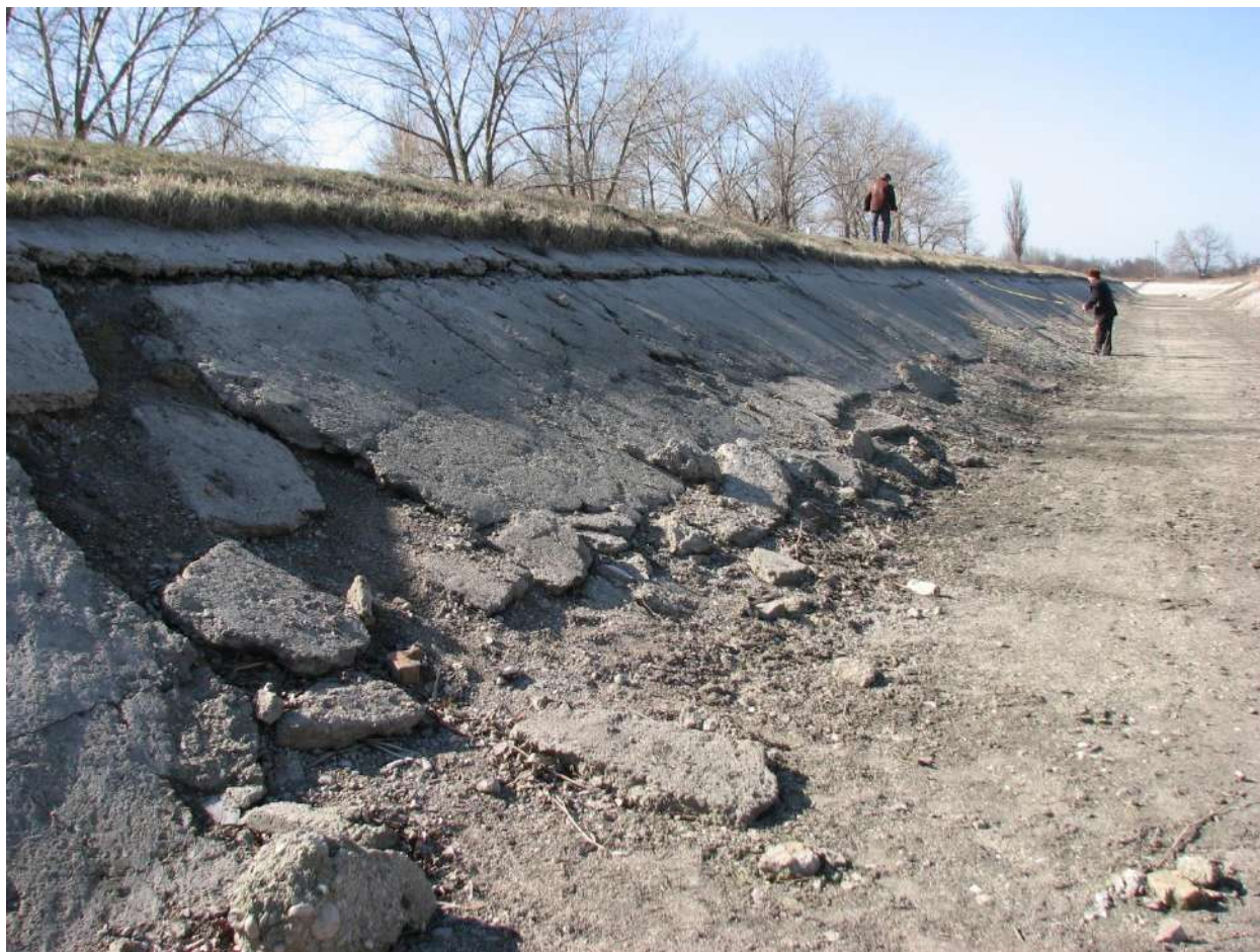
Рис. 1 – Технічний стан бетонного облицювання Інгулецького магістрального каналу до виконання ремонтних робіт (фото Є.В. Козленко).
